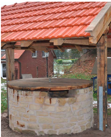
Abb. 5: Der für Fledermäuse hergerichtete Brunnen 6 mit Einflugspalte. Foto: Matthias Olthoff
