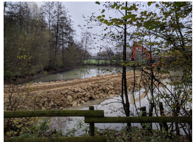
Fotos 5 / 6: Beginn der Baggerarbeiten mit Herstellung eines Walls aus Kalksandsteinbruch zur Abfuhr des Teichschlamms (Fotos 25.11.2019).
