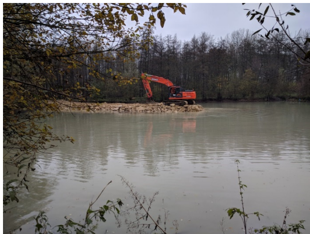
Fotos 5 / 6: Beginn der Baggerarbeiten mit Herstellung eines Walls aus Kalksandsteinbruch zur Abfuhr des Teichschlamms (Fotos 25.11.2019).
